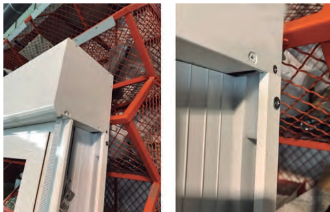
Figura 61. Embudo introducido en guía, con atornillado lateral
