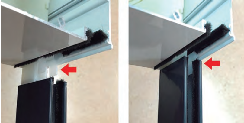
Figura 60. Unión ventana cajón
